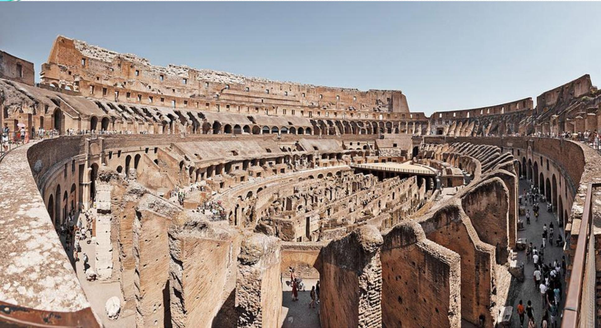
Colisée à Rome, monté au 1er siècle de notre ère, par des mortiers de Chaux coulés entre des parements de pierres, plus rapide, résistant et économique
